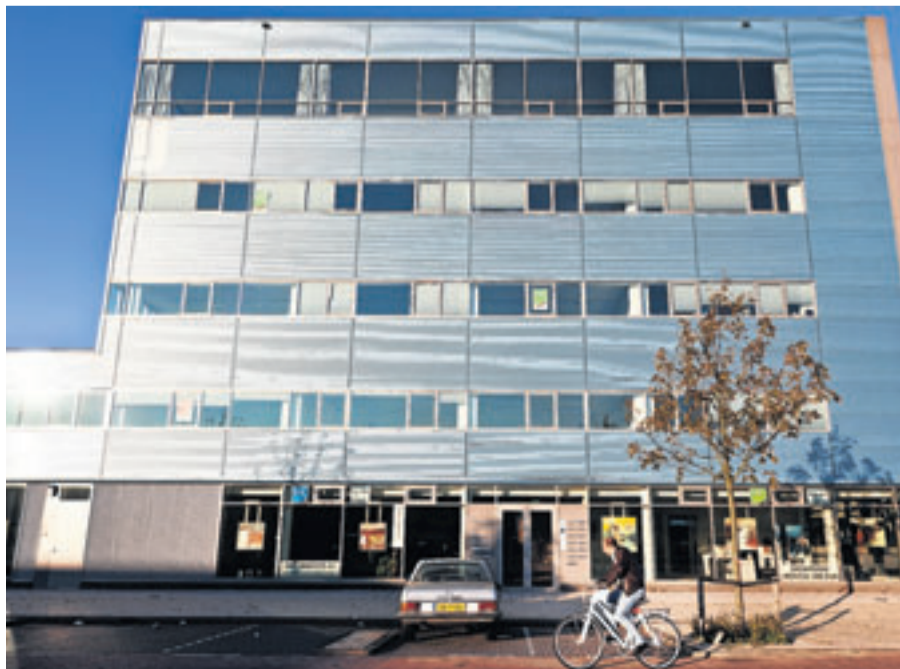
Het pand is afgewerkt met golfplaten, wat qua esthetiek niet hoog scoort.
